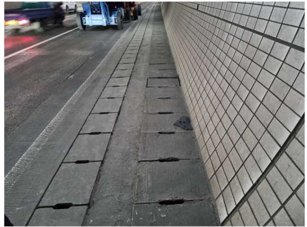
공동구 및 배수로 전경
